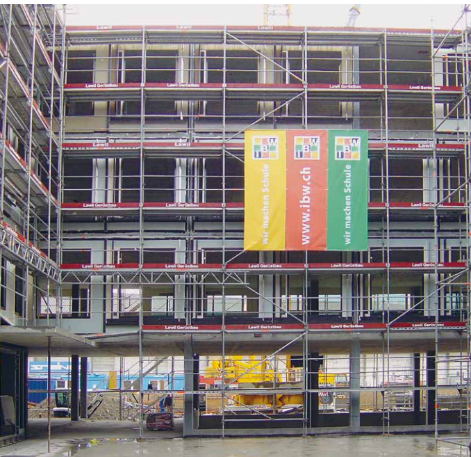
Der Bau des Hauptgebäudes an der Gürtelstrasse in Chur läutete 2008 ein neues Kapitel in der ibW-Geschichte ein.
